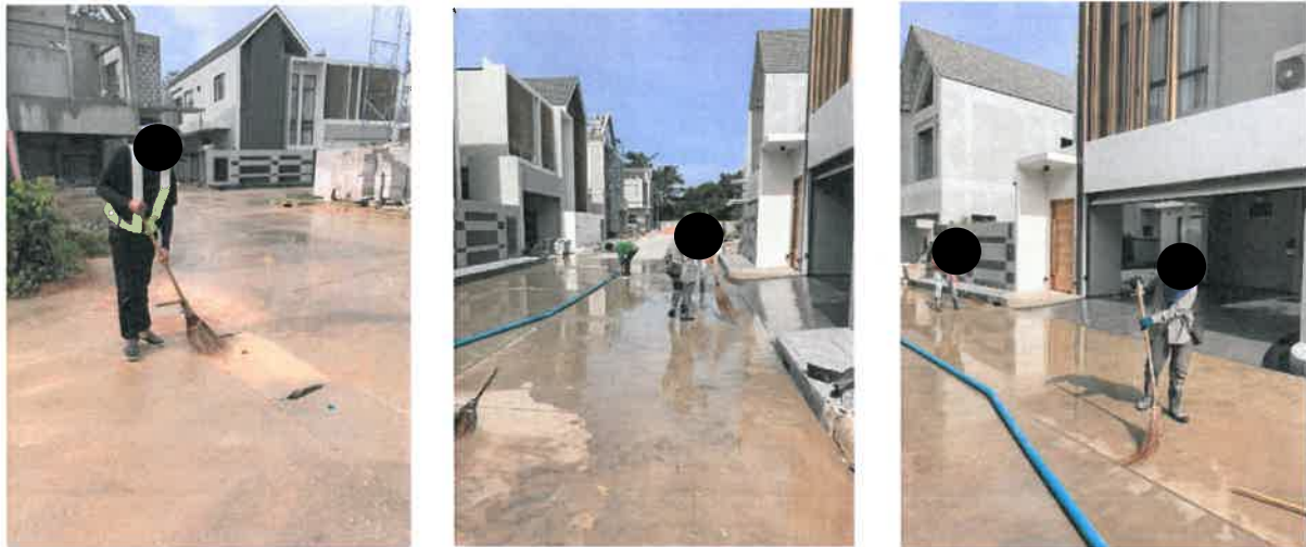
รูปที่ 2-4 แสดงเจ้าหน้าที่ฉีดพรมน้ำภายในพื้นที่ก่อสร้าง และทำความสะอาดบริเวณด้านหน้าพื้นที่ก่อสร้างตลอดแนว ถนนสาธารณะและภายในพื้นที่ก่อสร้าง
