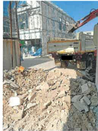
รูปที่ 2-13 แสดงการขนย้ายเศษวัสดุที่ไม่ใช้แล้วออกจากสถานที่ก่อสร้าง
