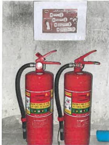
รูปที่ 2-36 แสดงถังดับเพลิงเคมีภายในบริเวณพื้นที่ก่อสร้าง
