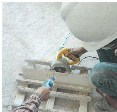
รูปที่ 2-15 แสดงการตัดกระเบื้องปูพื้นใช้วิธีตัดเปียก เพื่อป้องกันฝุ่นละออง
